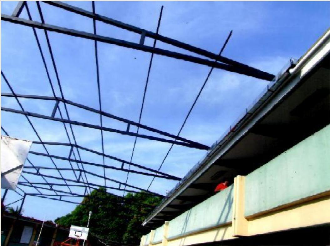
Para la construcción del Techado se coloco el armazón para colocar las láminas.
